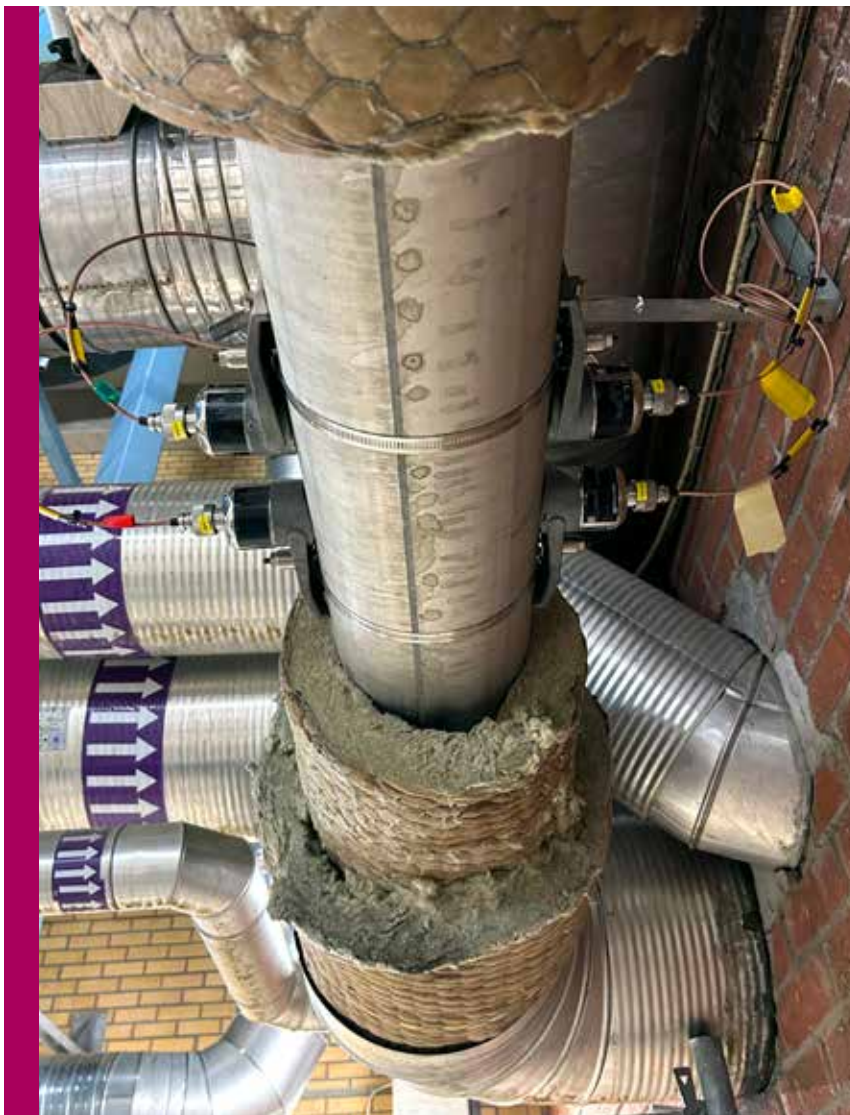
Clamp-on med två sensorpar möjliggör montage nära rörböj – flödesriktning från väggen.
